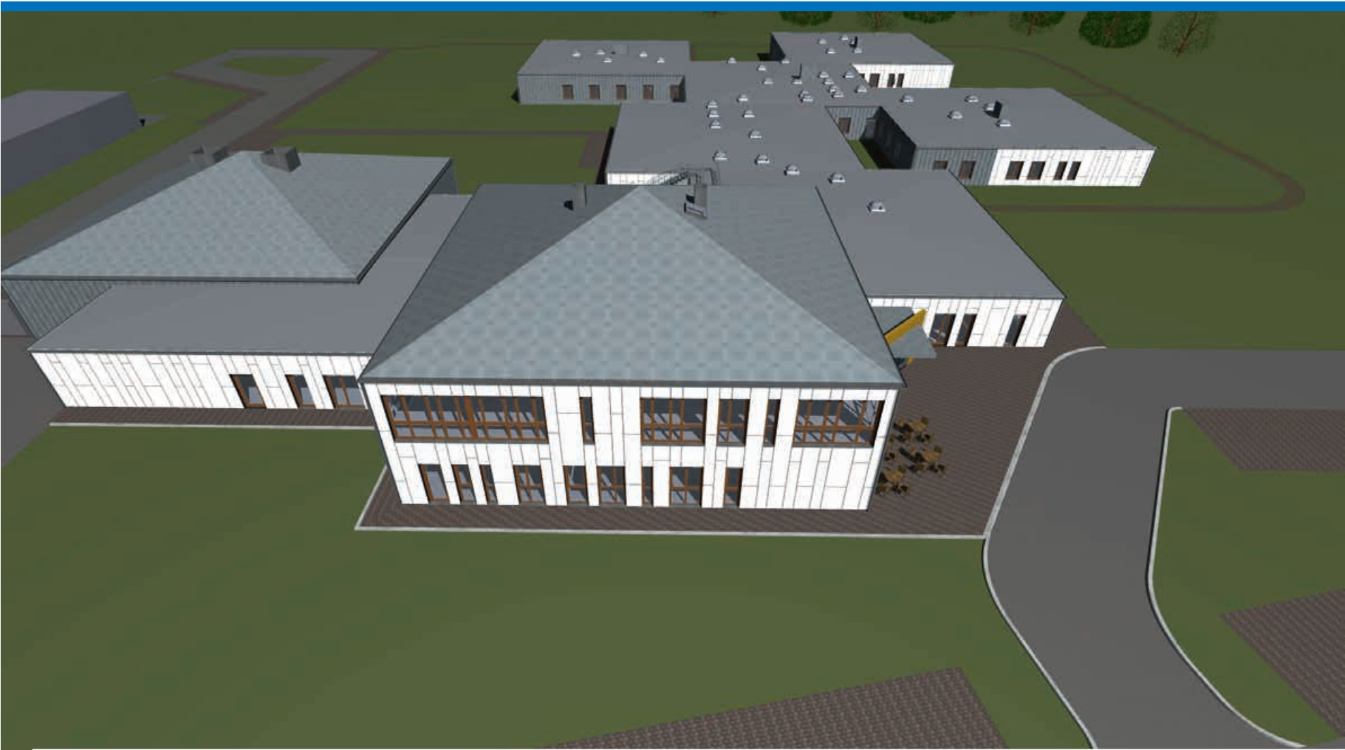
Das neue Werk 4: Sieben miteinander verbundene Gebäudeteile bieten Arbeitsplätze sowie Therapie- und Sozialräume für rund 180 Personen.
