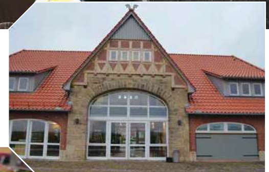
Das denkmalgeschützte Torhaus von 1923 erstrahlt in neuem Glanz.
