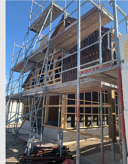
Nebengebäude mit Abfall-Entsorgung und Fahrradgarage
